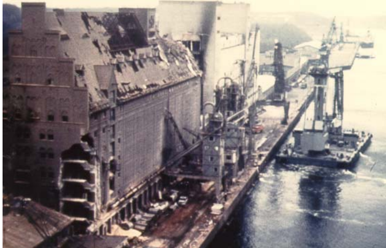
Bild 1.4 Rolandmühle in Bremen nach der Staubexplosion 1979
