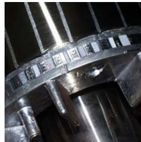
Bild 37.3.2 Temperaturindikatoren am Kurzschlussring vor dem Einbau
