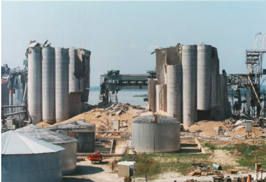
Bild 28.3.3 Auswirkungen einer Silo-Explosion bei SEMABLA, Blaye, Gironde; Foto: VSD
