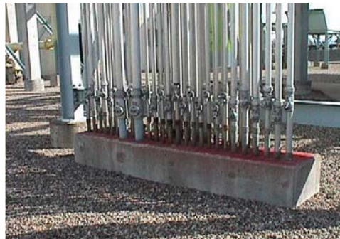
Bild 30.11.4 Beispiele elektrischer Leitungsinstallation im Conduit-System links: Quelle Worthington Corp rechts: Quelle CEAG
