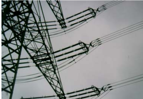
Bild 12.1.4 Bündelleiter bei HS-Freiluftübertragung zur Verminderung der Korona-Verluste
