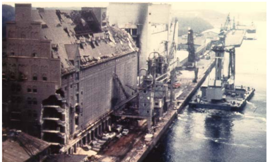
Bild 18.6 Rolandmühle in Bremen nach der Staubexplosion 1979
