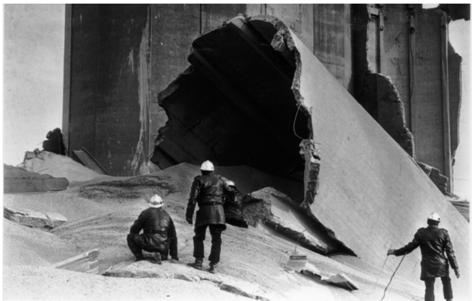
Bild 18.4 Überreste des Silos einer Malzfabrik nach einer Staubexplosion (1982) (Bilder 18.3 und 18.4 zur Verfügung gestellt von "Républicain Lorrain")
