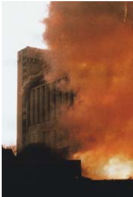
Bild 24.0.1 Staubexplosion im Kraftfutterwerk Würzburg (1972)
