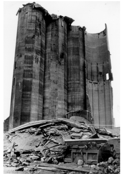
Bild 18.3 Silo einer Malzfabrik in Metz nach einer Staubexplosion (1982)
