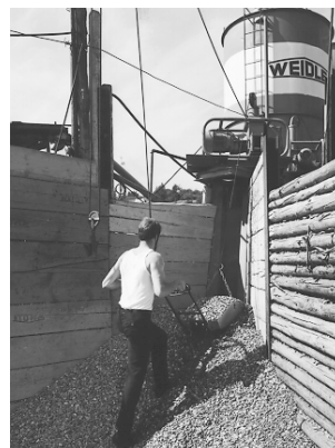
Bild 11.1.1 Anwendungsbeispiel für Elektromotoren mit wechselnder Belastung während eines Arbeitsspiels
