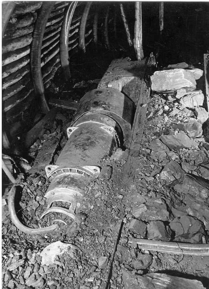
Bild 9.1 Typischer Betrieb unter Tage (mit freundlicher Genehmigung der Fa. LOHER AG)
