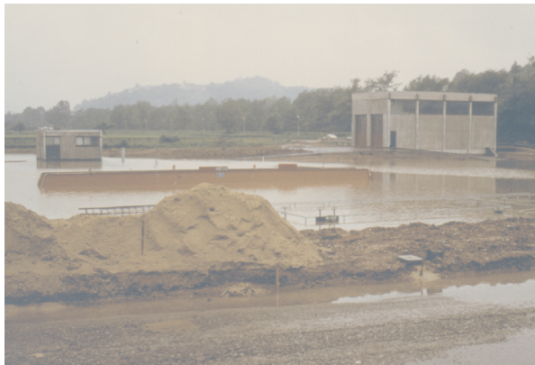
Bild 4.4.7 Hochwasser in einem Klärwerk mit kurzzeitiger Überflutung der Antriebsmotoren für Räumbrücken und Förderschnecken
